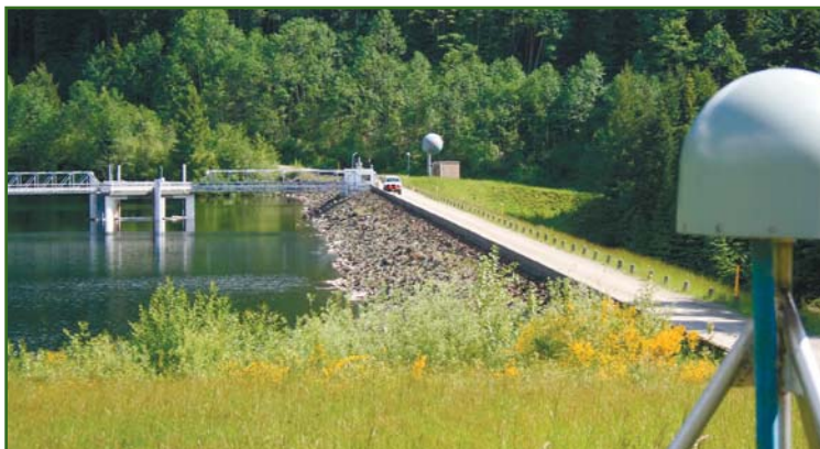
Рис. 2 Мониторинг деформаций и смещений гидротехнического сооружения ( www.trimble.com )
